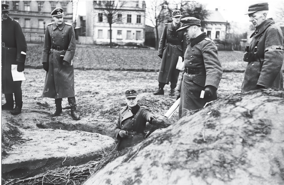
El General de División Hellmuth Reymann durante la inspección de una posición de ametralladora junto a soldados y miembros de la Volkssturm.
